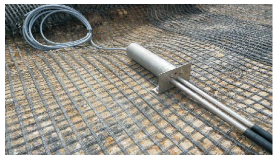
Kopfmontage am Geogitter
