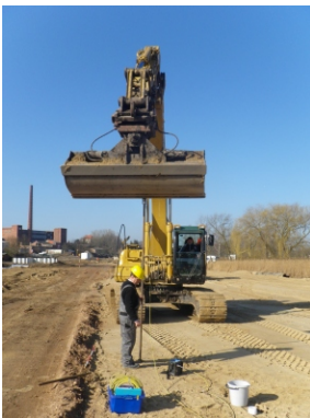
Einpressen mit Bagger
