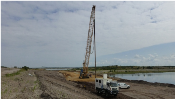
Überwachung von RDV-Arbeiten
